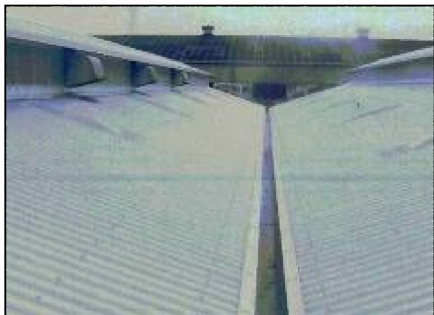
工場屋根の遮熱化
