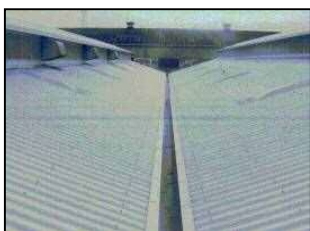
工場屋根の遮熱化
