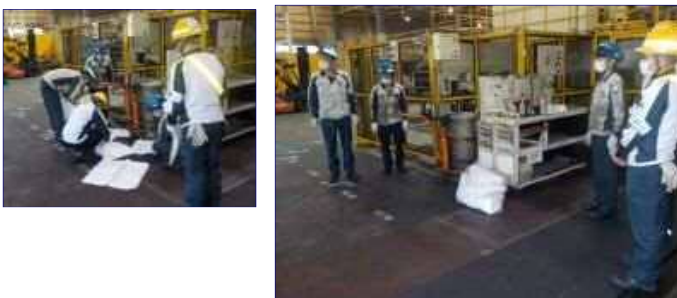
漏えい油の回収作業
